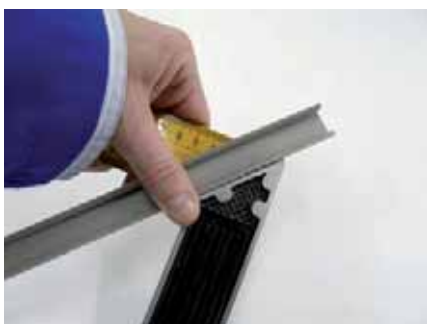
↑ Figura 2.74. Marcado de canaleta con ayuda del inglete de la escuadra.
