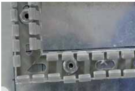
↑ Figura 2.76. Unión de canaletas y tapas en inglete.
