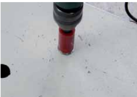
↑ Figura. 2.65. Perforado con corona.
