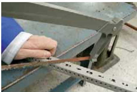
↑ Figura 2.75. Corte de canaleta y eliminación de rebaba.
