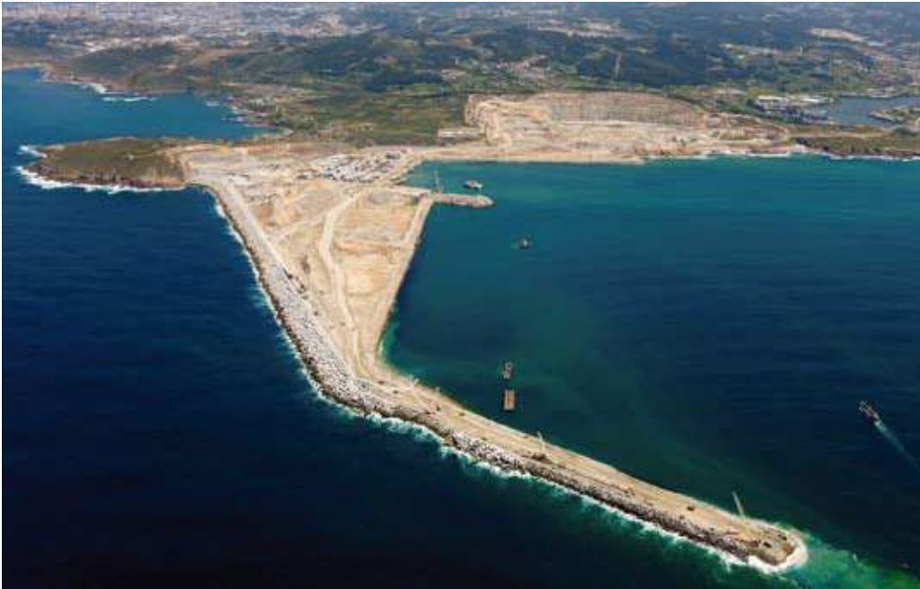
Obras de construción do porto exterior da Coruña. (Foto: faltadeingenieria.files.wordpress.com).
