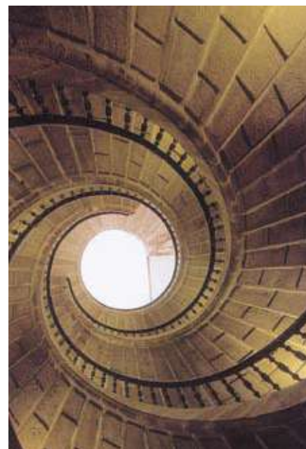
Escaleira de caracol en San Domingos de Bonaval, c. 1700 (Domingos de Andrade). Orixina escaleira tripla que comunica as estancias dos tres andares aos que dá servizo.
