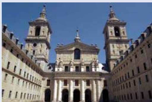
Fachada da igrexa do mosteiro do Escorial (X.B. Herrera).
