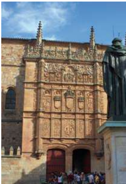
Fachada da Universidade de Salamanca, c.1525.
