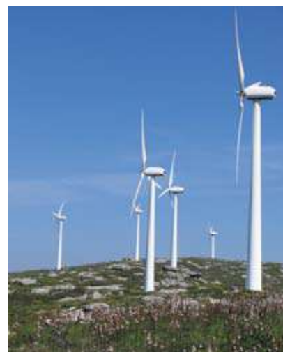
Parque de produción de enerxía eólica.
