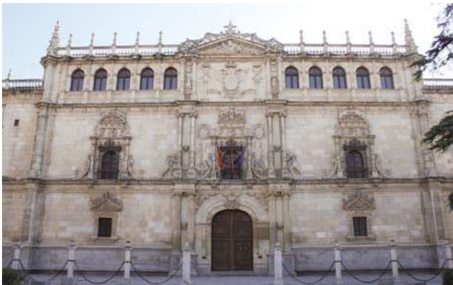
Fachada da Universidade de Alcalá de Henares, c.1543 (Rodrigo Gil de Hontañón).
