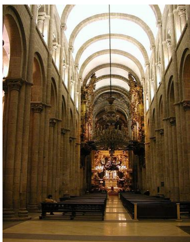
Nave central do brazo maior: bóveda de canón con arcos de faixa
