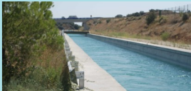
Canalización de ríos
