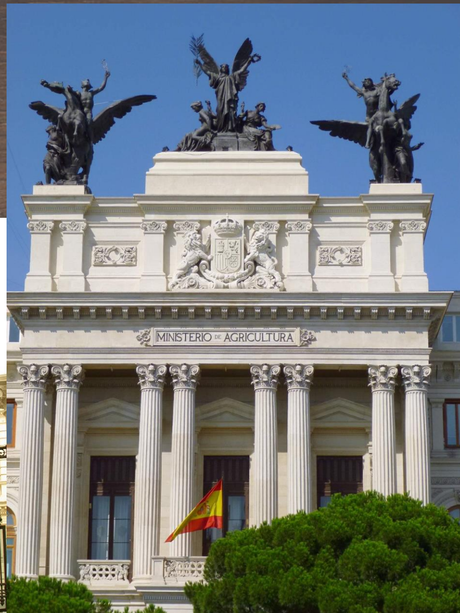
Cuerpo central sobresaliente.
