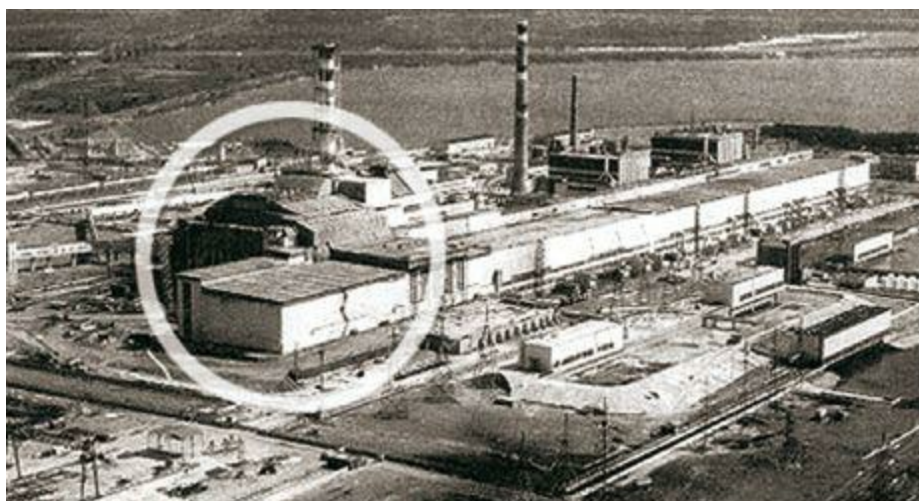
El sarcófago de Chernóbil en el extremo del edificio donde el resto de centrales siguieron en marcha.
