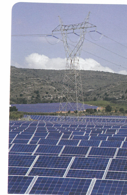
Figura 9.28. Las células fotovoltaicas transforman la energía solar en energía eléctrica. Actualmente, la eficiencia de este proceso es casi del 40 % en los dispositivos más eficientes.
