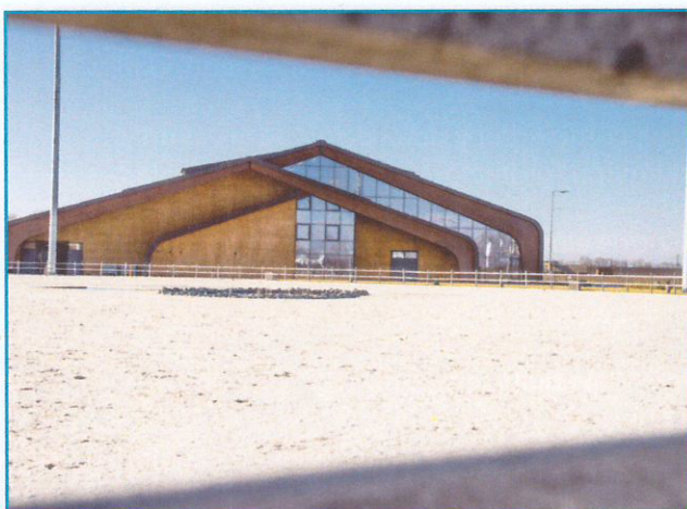
Figura 1. Pista de arena de sílice.
