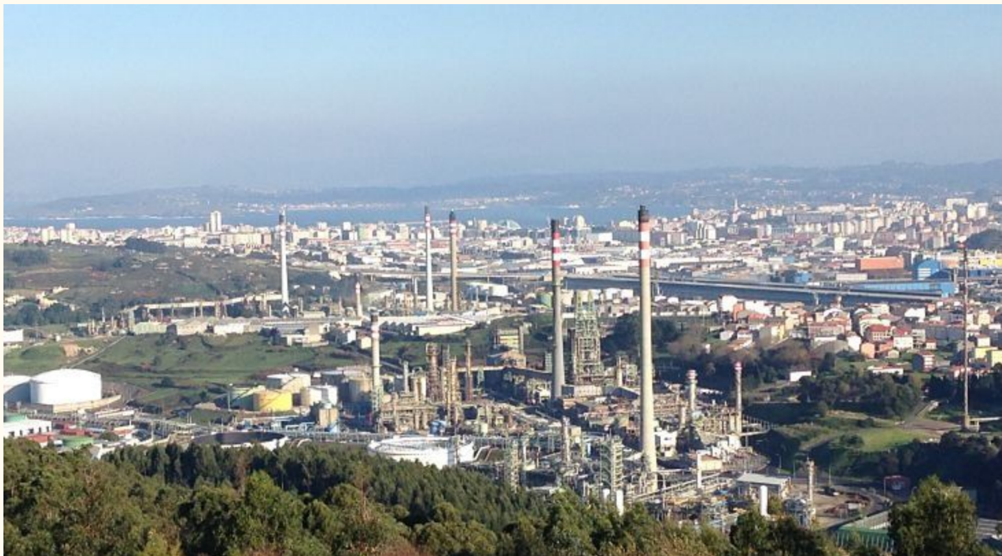
REFINERÍA A CORUÑA
