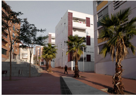
2. REMODELACIÓN URBANA Viviendas del Gobernador, Barcelona
