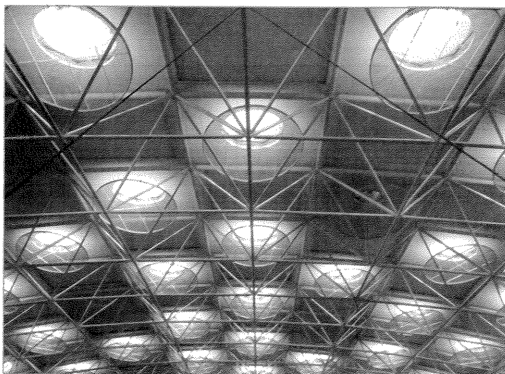
Fig. 1. Estructura espacial formada por triángulos unidos mediante articulaciones esféricas.
