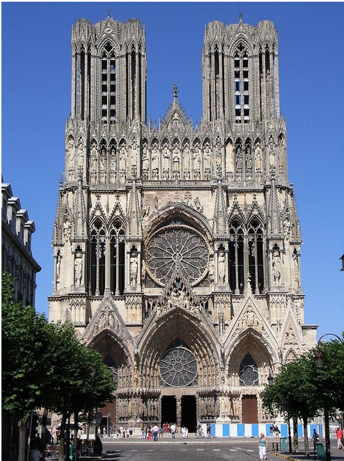
Fachada occidental. Catedral de Reims
