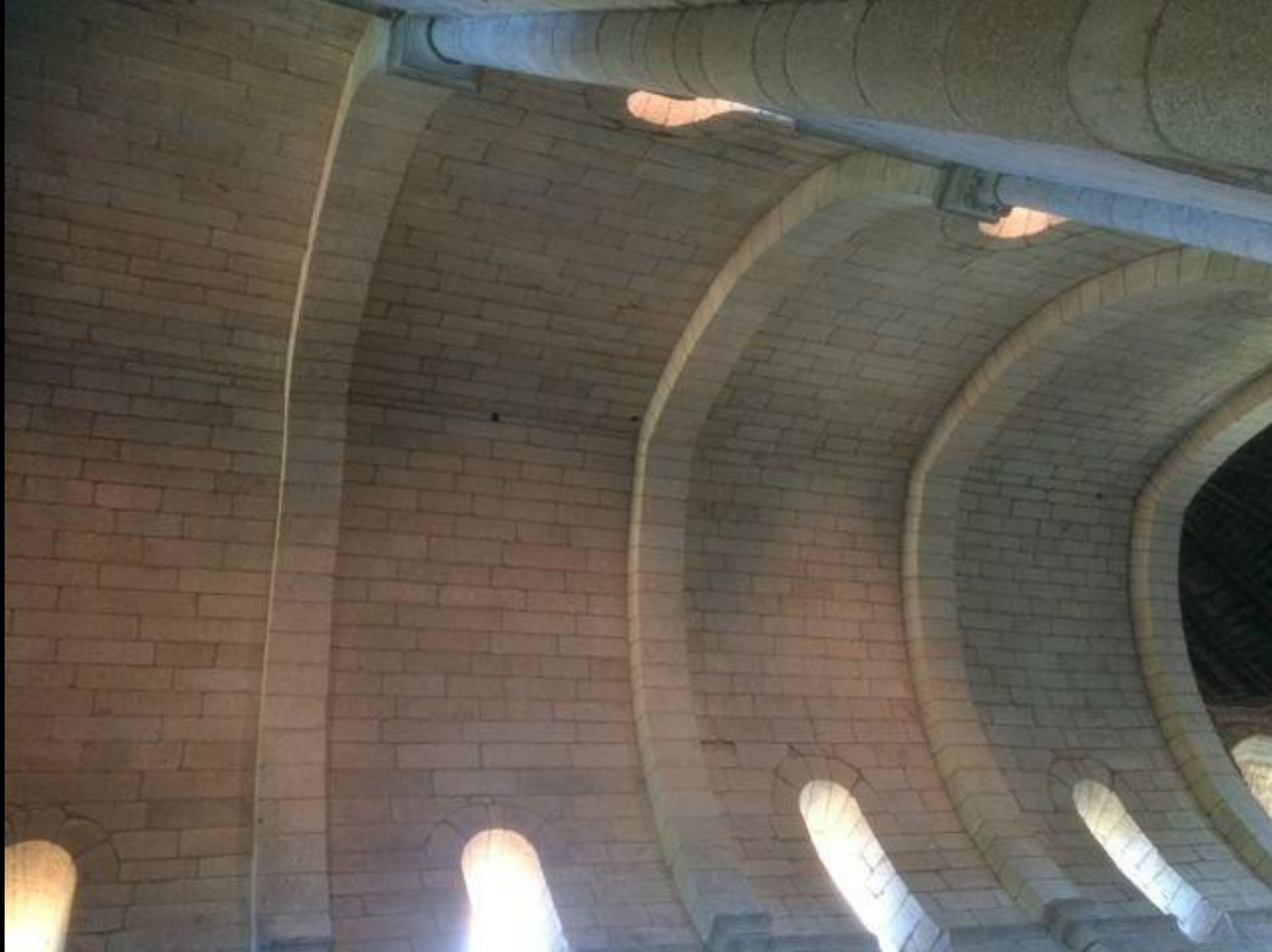
A bóveda da nave central é de canón apuntado con faixaóns. As ventás de médio punto ábreñse no arranque da bóveda
