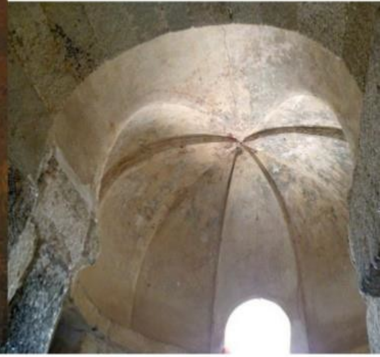
Cubierta del ábside principal.
