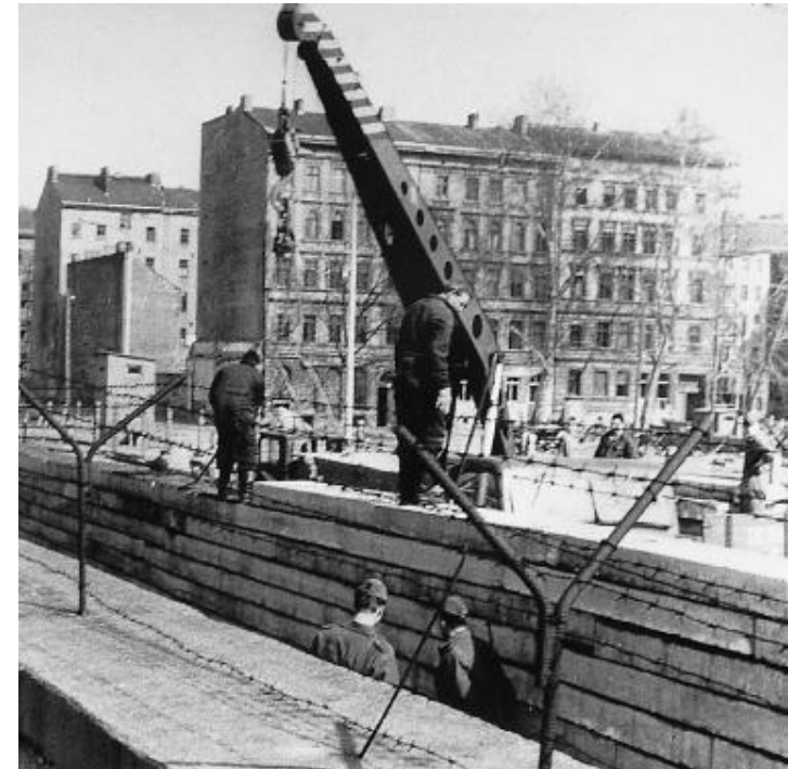
A construción do muro
