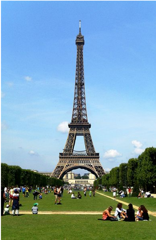
La Torre Eiffel ( Tour Eiffel , en francés ), inicialmente nombrada torre de 330 metros , es una estructura de hierro pудelado diseñada por el ingeniero francés Gustave Eiffel y sus colaboradores para la Exposición universal de 1889 en París
