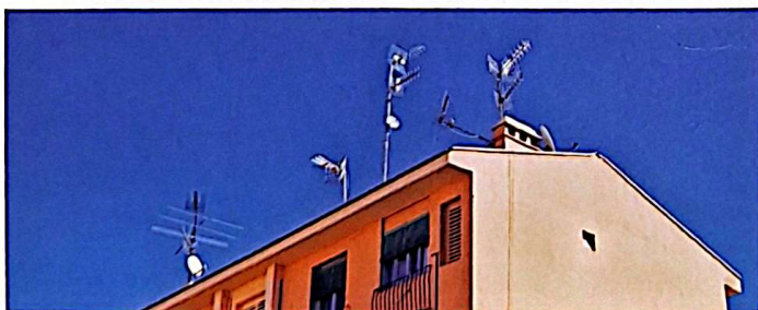
Figura 1.2. Edificio con varias antenas.
