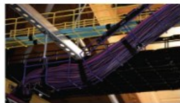
Fijado de mazos con cintas de velcro (cortesía de Leading Edge Design Group).
