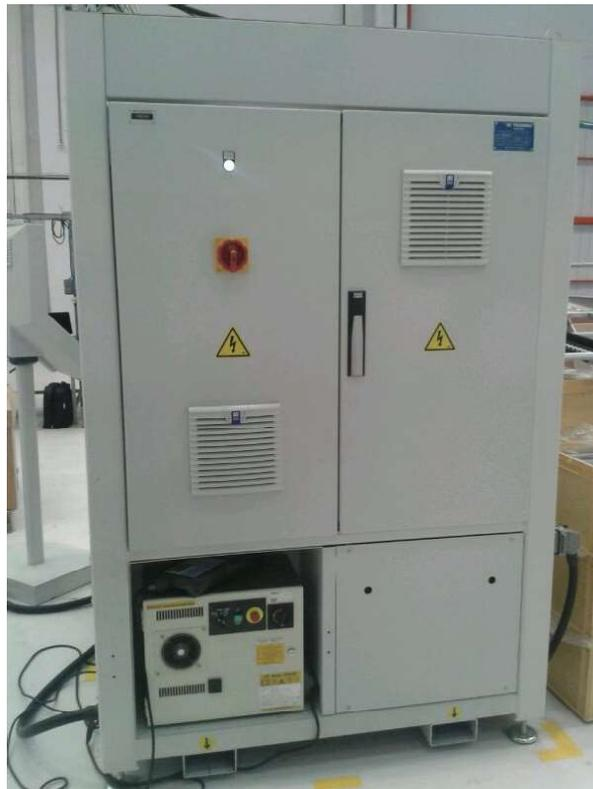
**Ilustración 1: Señalización riesgo eléctrico**
