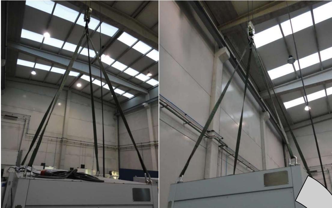
Ilustración 1: Disposición eslingas para levantamiento de máquina
