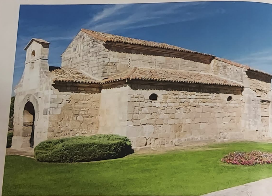
Igrexa de San Xoán, Baños de Cerrato (Palencia). Recesvinto ordenou a súa construción a mediados do século VII.
