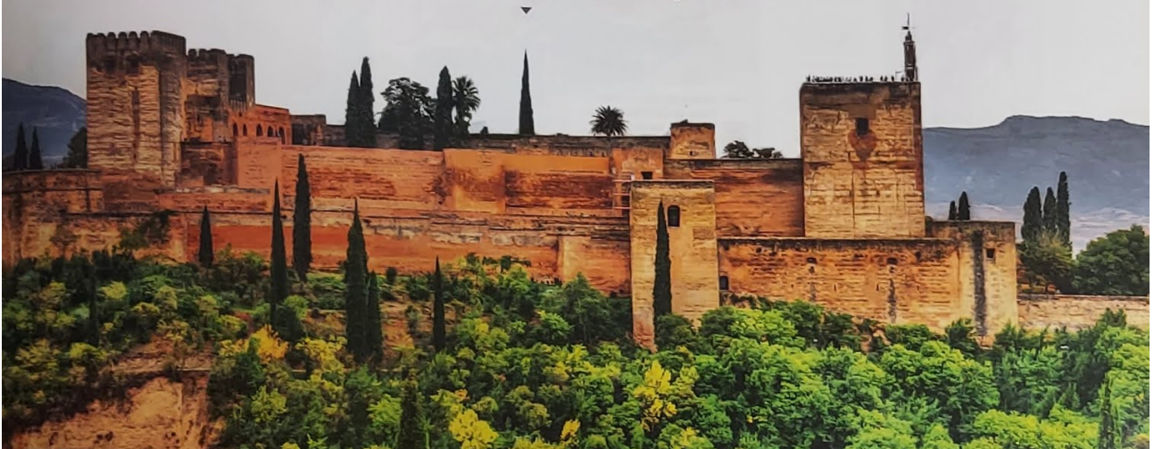
Vista panorámica da Alhambra de Granada, recinto palaciano levantado sobre unha antiga fortaleza.
