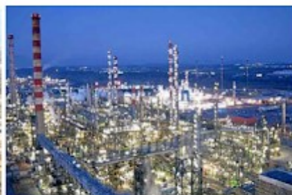
Figura 3. Refinería de Tarragona. Actual Fonte: Deia
