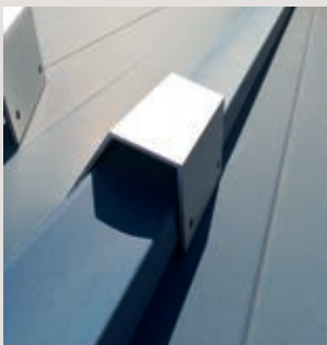
Colocación del soporte S3 sobre la greca.
