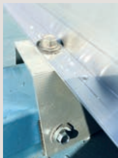
Atornillar lateralmente el soporte a la greca utilizando los mecanizados y atornillar el perfil al soporte utilizando la línea de taladro.
