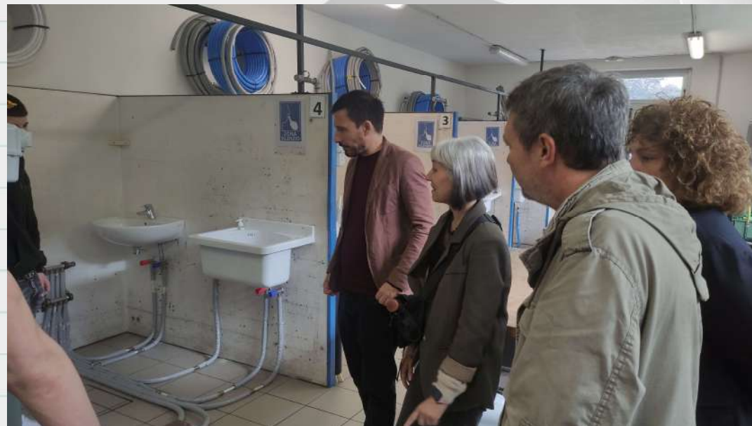
Aula-taller Técnico en sistemas termohidráulicos
