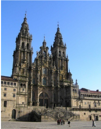
Casas e Novoa, Fachada do Obradoiro
