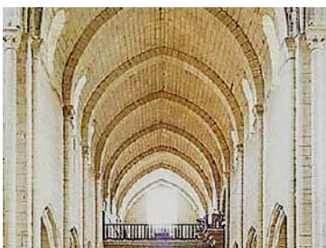
Bóveda canón apuntado
