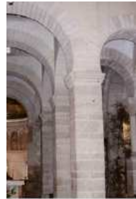
Pilastra: piar non excesivamente groso adosado ao muro. (esquerda)
