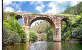
Ponte sobre o río Bibei (Provincia de Ourense)
