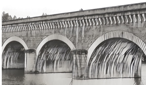
Fig 1: Pont-canal du Cacor (Moissac, Francia)
