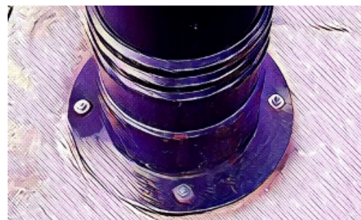
Fig 3: Sujeción de una farola: Una manera de asegurar la estabilidad de los objetos es el anclarla al suelo.
