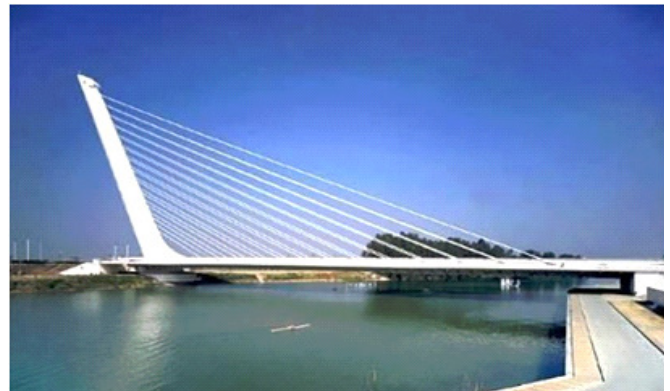
Puente atirantado, El Alamillo, Sevilla.
