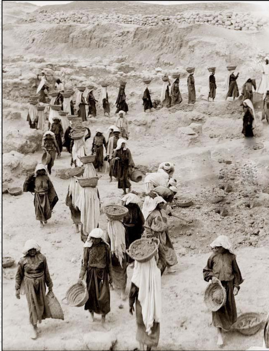
Cargando terra, Próximo Oriente, 1925
