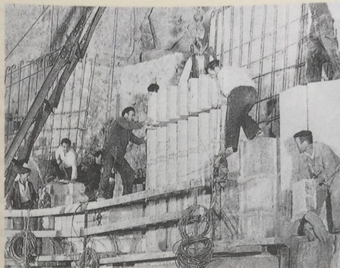
DOC. 10. TRABALLOS DE CONSTRUCCIÓN DO VAL DOS CAÍDOS.
