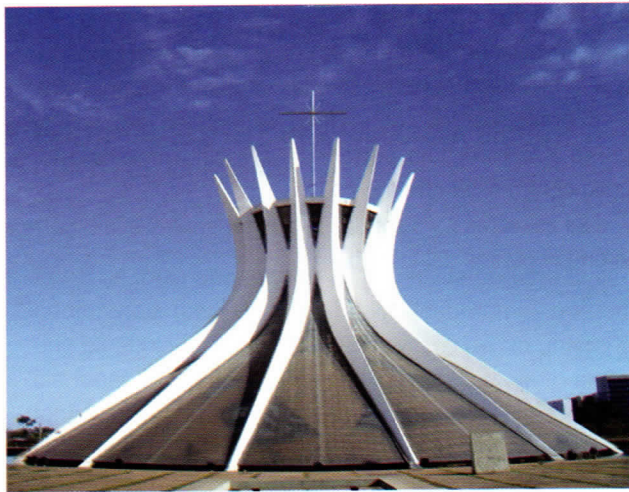
CATEDRAL DE BRASILIA (1970). OSCAR NIEMEYER. ESTRUCTURA ARQUITECTÓNICA DE PERFIL HIPERBÓLICO.
