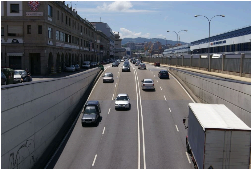
Rehabilitación Casco Vello de Vigo
