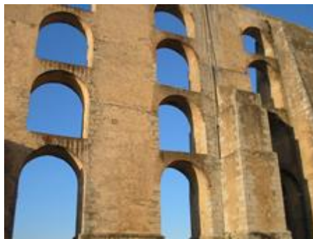
Arcos de medio punto y contrafuertes del acueducto de Elvas
