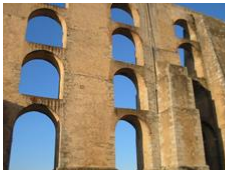
Arcos de medio punto y contrafuertes del acueducto de Elvas
