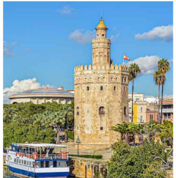
Torre del Oro (Sevilla)
