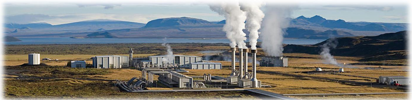
Central xeotérmica en Islandia( commons.wikimedia.org )
