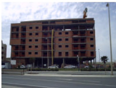
Aquellos pisos están en construcción.
