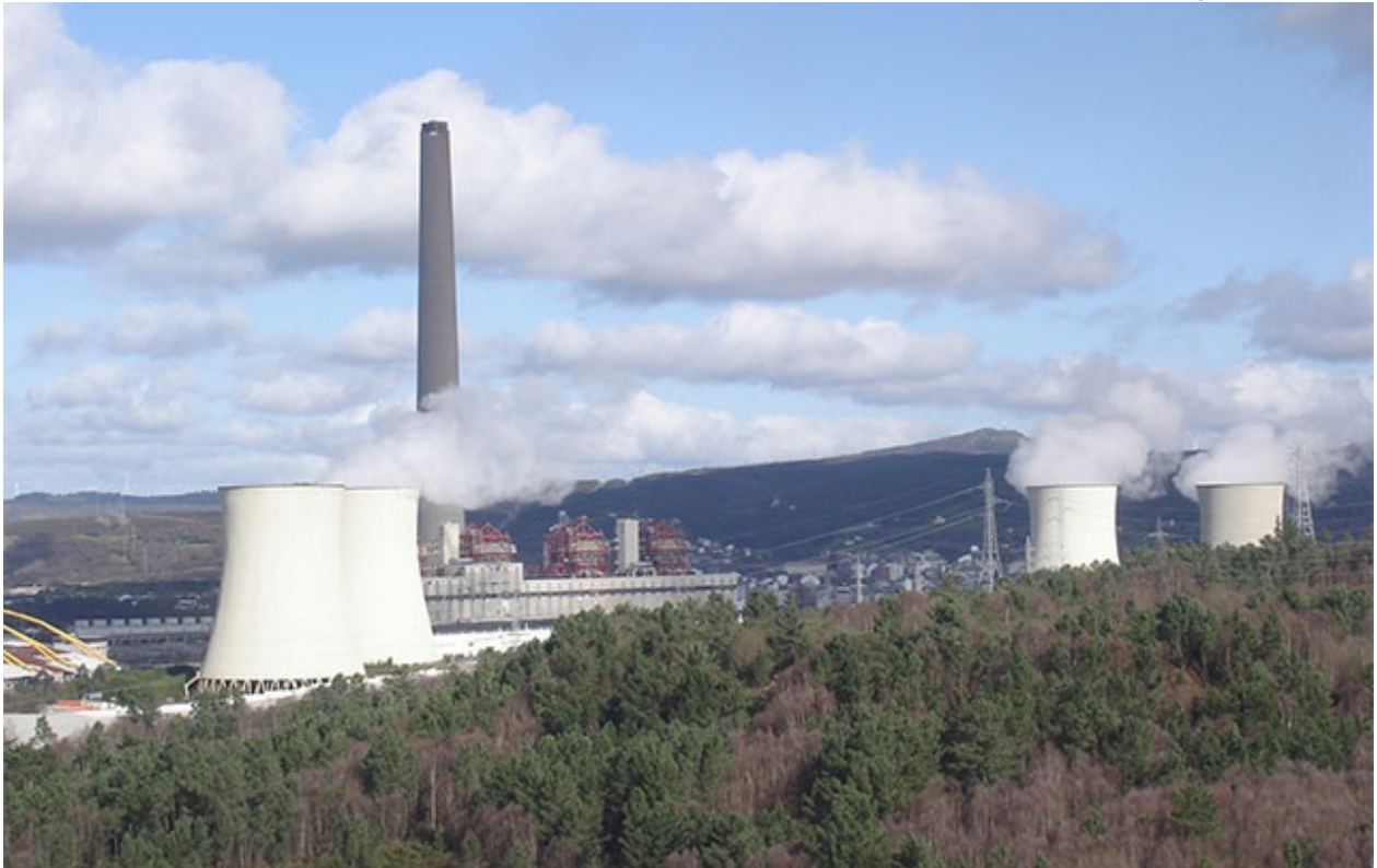
Central térmica de As Pontes, en A Coruña
