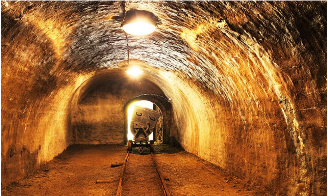
Túnel propio da minería subterránea
