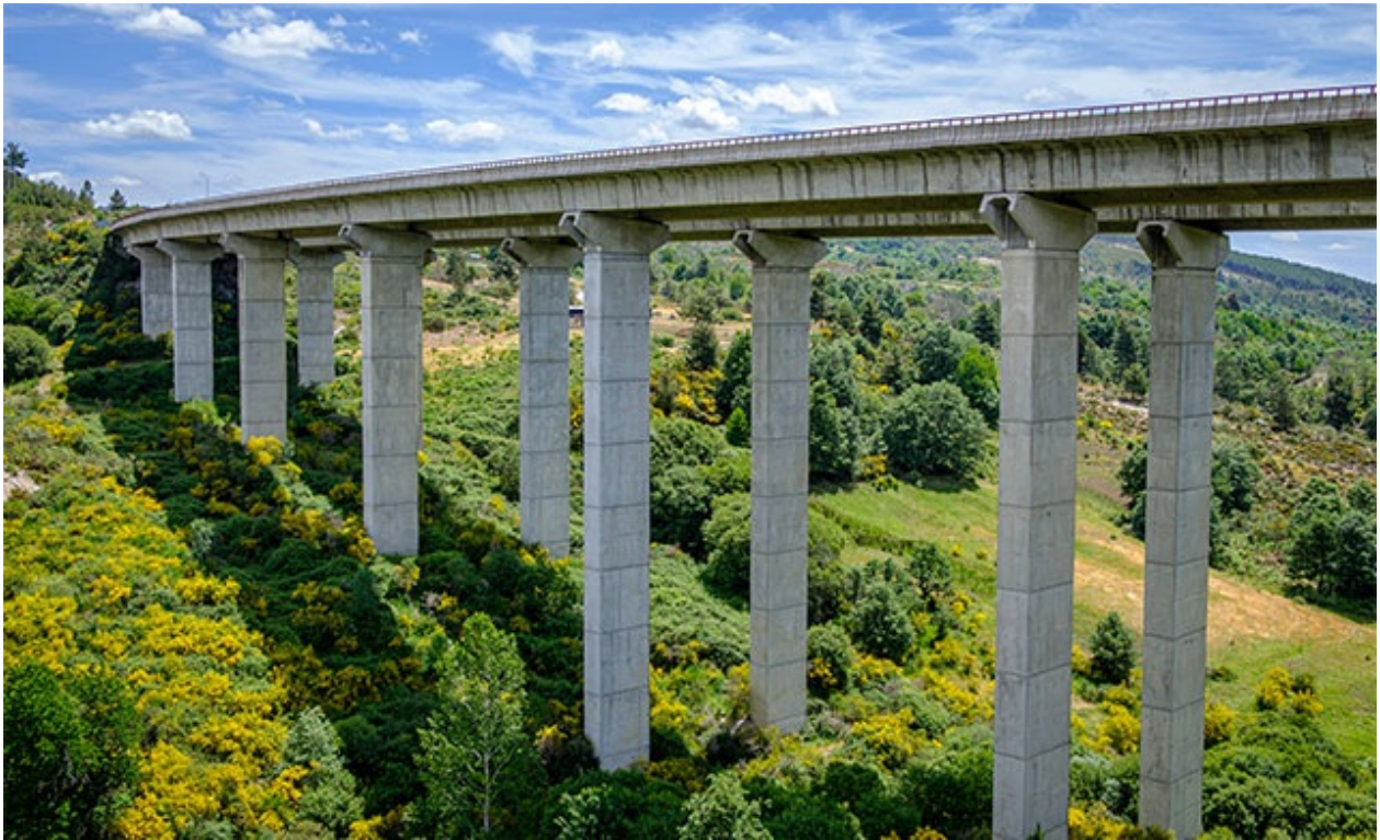
Viaduto que conecta Galicia coa meseta, na provincia de Ourense.
