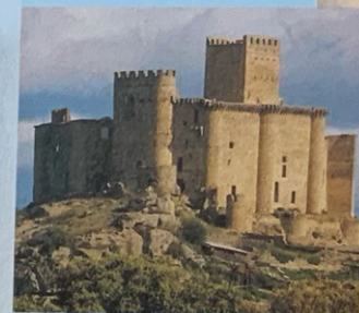
5. Construcción de castelos.
