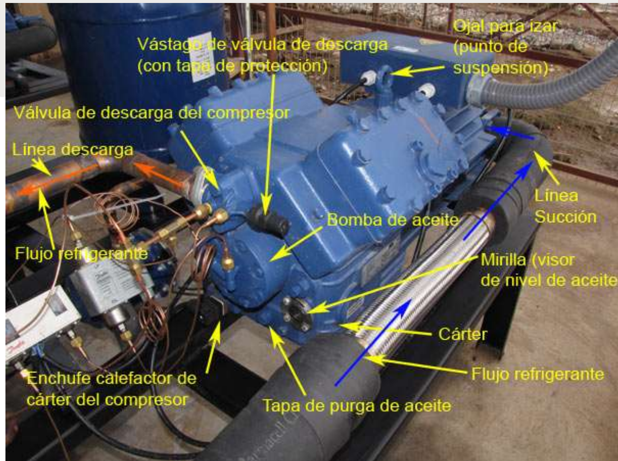
Partes de un compresor semihermético (II)
