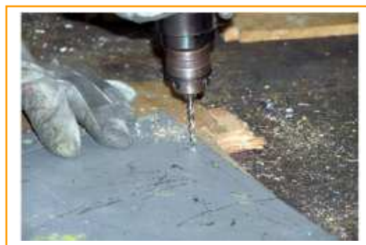
Fig. 23 : Taladrado de chapa con taladradora manual.
