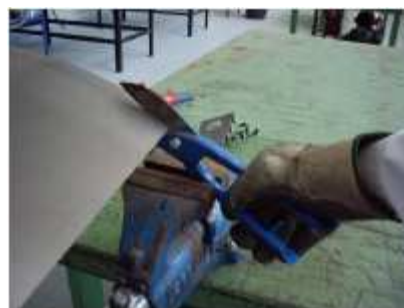
Figura 21. Corte de chapa con tijeras
