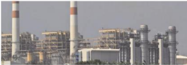
Figura 1.1. Casi toda la energía eléctrica que consumimos se produce en las centrales eléctricas.
