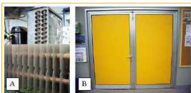
Fig. 29: A) En primer plano, evaporador con aletas de aluminio. B) Puerta con estructura metálica de aluminio.
