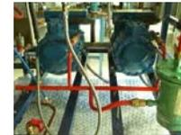
g) Debido a los problemas de corrosiones y considerando que las tuberías necesarias en las instalaciones de CO2 son relativamente de pequeño diámetro será preferible el uso de **tuberías de cobre o acero inoxidable**, salvo que se adopten medidas que eviten dichas corrosiones.
