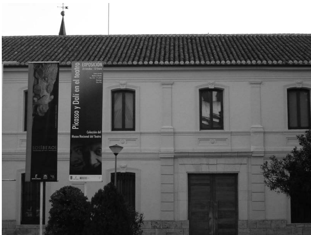
Fig. 1. Antiguo convento de la Merced. Exterior. Fachada principal
