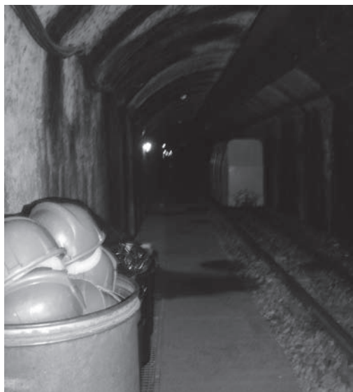
Fig. 4. Acceso a la mina
