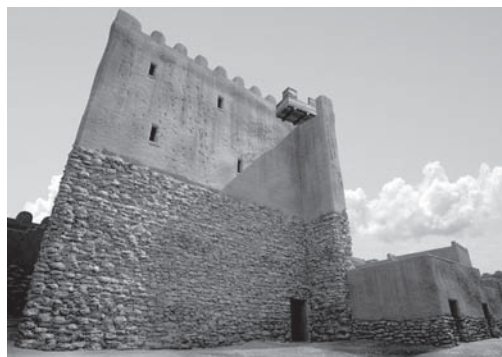
Fig. 16. Vista parcial de la fachada meridional del castillo-palacio de la fase ALP III. Se observan la puerta de entrada y el imponente contrafuerte
