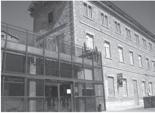
Fig. 1. Entrada al museo y edificio de servicios
