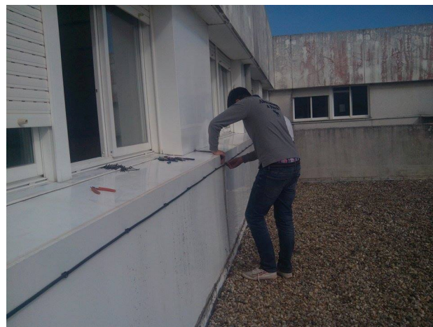
Suxeición da fibra óptica cas bridas
